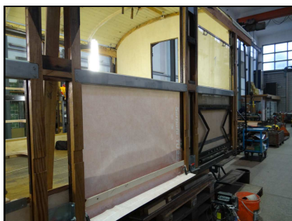
Kunststofffolien führen Wasser aus dem Fensterbereich nach aussen
