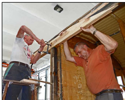
Einsetzen eines Teiles des Dachbalkens
