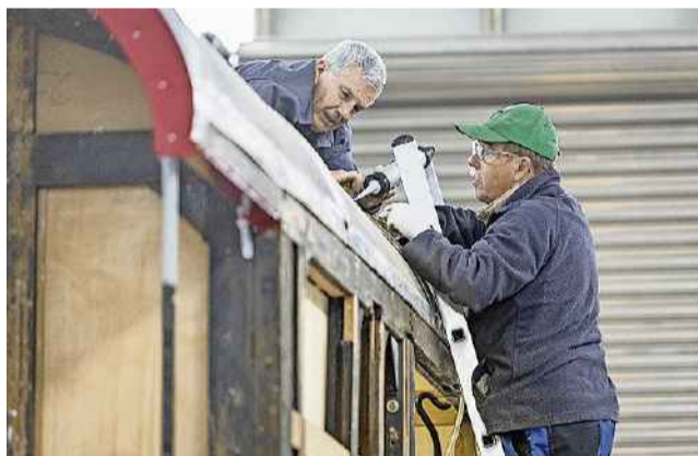
Auch am Dach muss jedes Detail stimmen.
