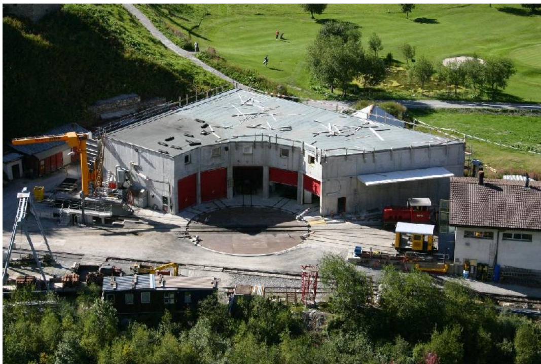
Baustelle Werkstätte Realp (Foto: Hans W. Berger)
