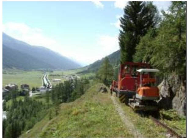
Bauzug vor Oberwald
