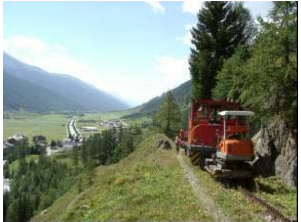
Bauzug vor Oberwald
