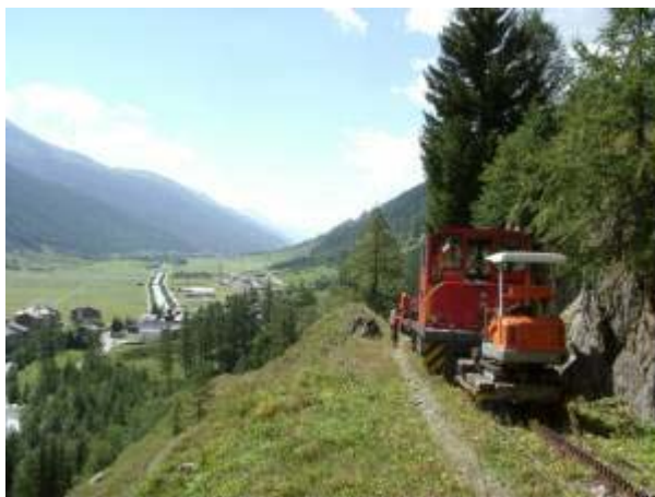
Bauzug vor Oberwald
