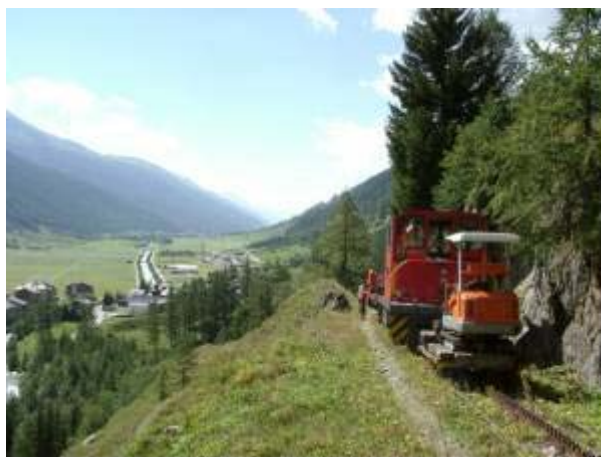
Bauzug vor Oberwald
