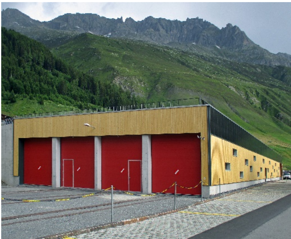
Die Wagenremise fügt sich mit ihrem gefälligen Äusseren gut in die Umgebung. Die Photovoltaikanlage auf der Südseite nutzt die Bergsonne. (Foto: Marcel Pflüger)
