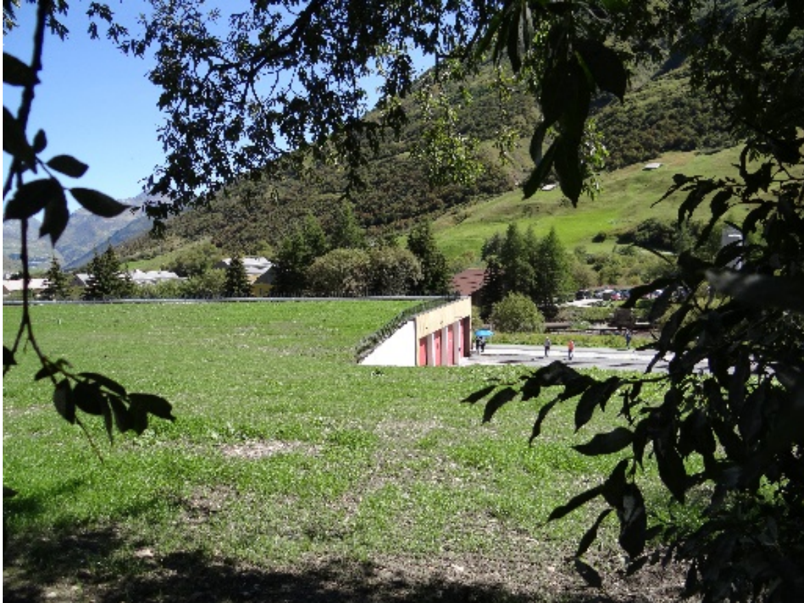
Von der Furkastrasse aus zeigt die Remise ihr begrüntes Dach. (Foto: Heinz Unterweger)
