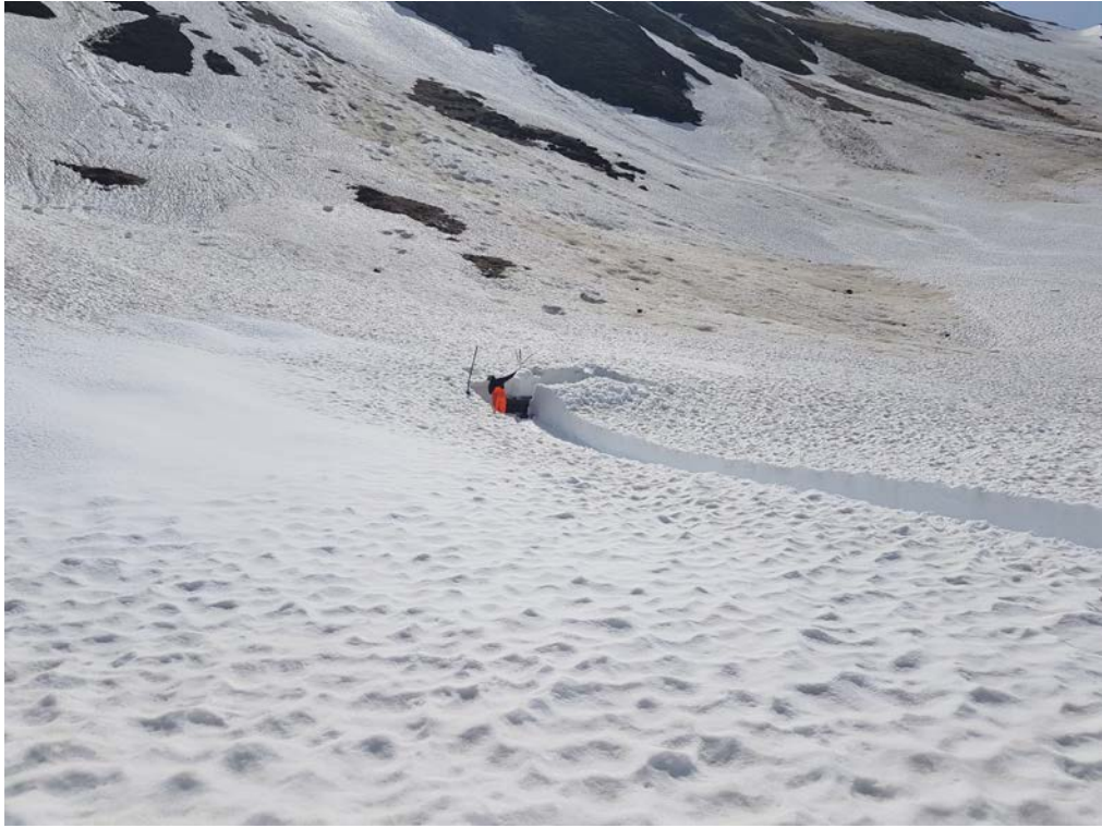
Die Oberkante des Westportals des Scheiteltunnels ist freigelegt.
