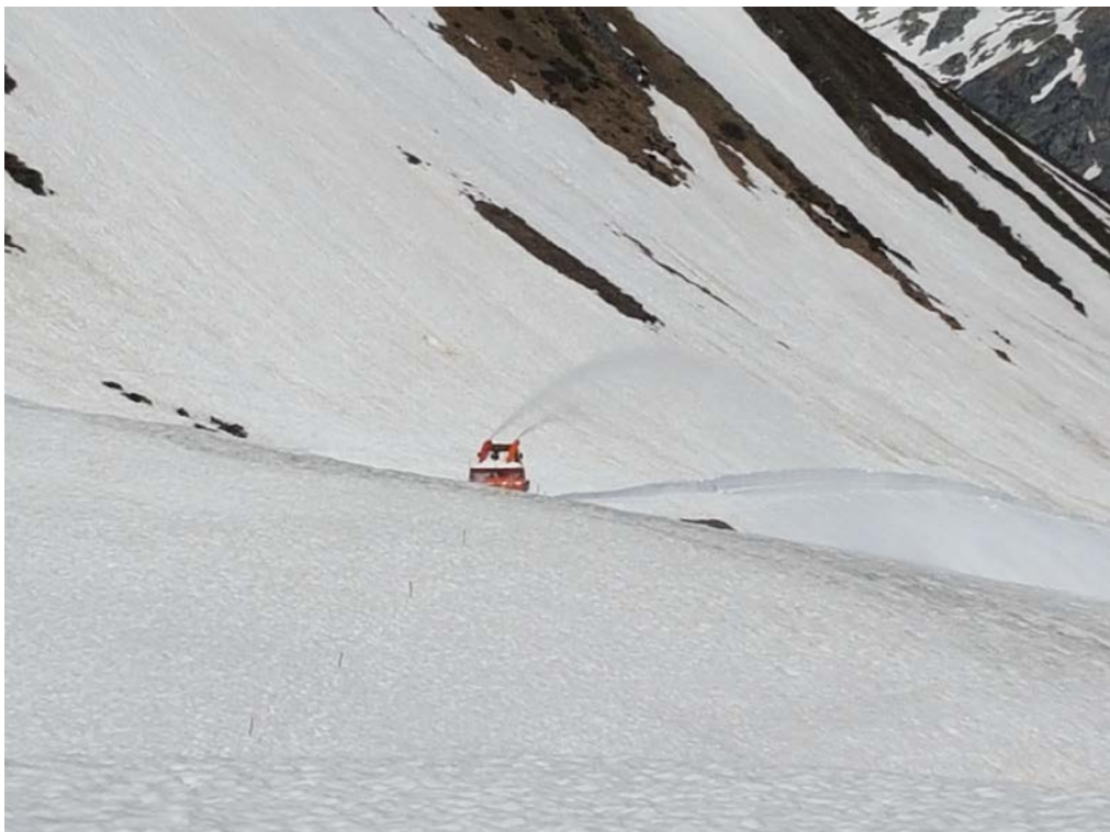
Die INTRAC Fräse arbeitet sich langsam zum Westportal des Scheiteltunnels vor.
