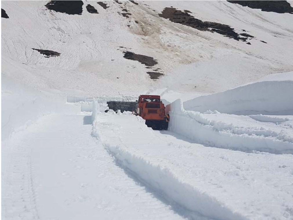
In der Station Muttbach Belvédère räumt die INTRAC Fräse von Thomas Holder Schnitt für Schnitt den Lawinenschnee von den Bahnanlagen. Im Hintergrund ist das Westportal des Scheiteltunnels erkennbar.
