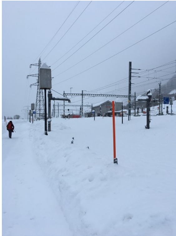
Auf den Gleisanlagen der Station Oberwald liegt rund 1 m Schnee.
